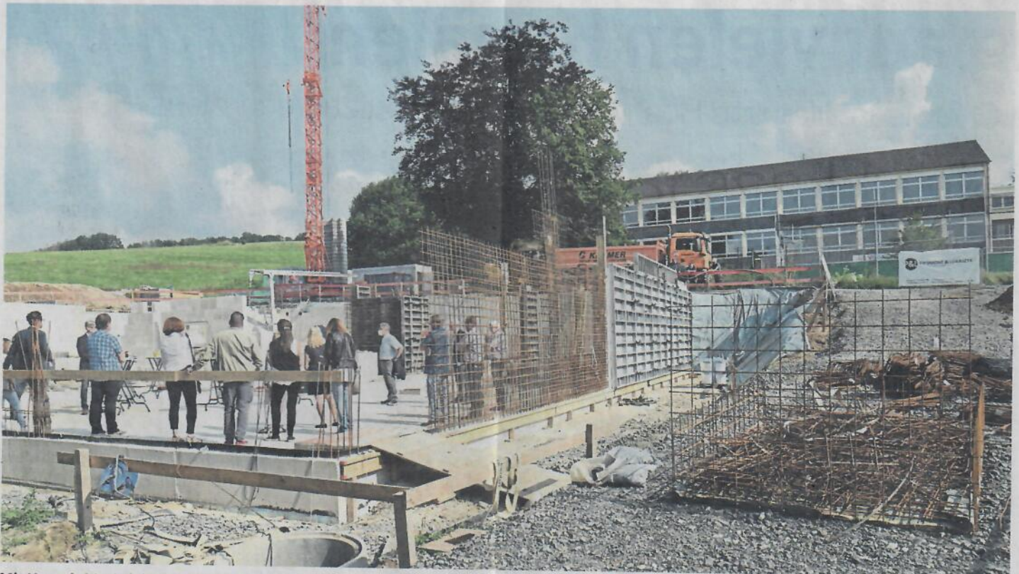
Mit Ungeduld wird die Fertigstellung der neuen Halle unterhalb der OGGs Vilkerath erwartet. Viele Gäste feierten die Grundsteinlegung mit.
